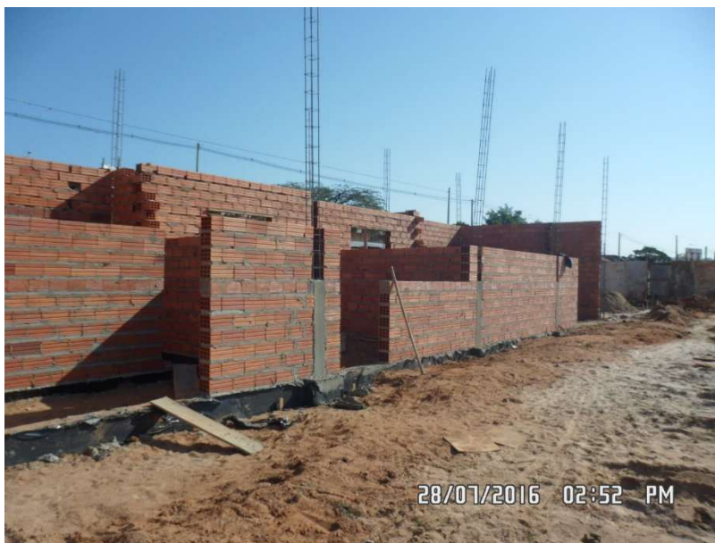
Imagem 2 – sistema estrutural e alvenaria após execução em 2016
