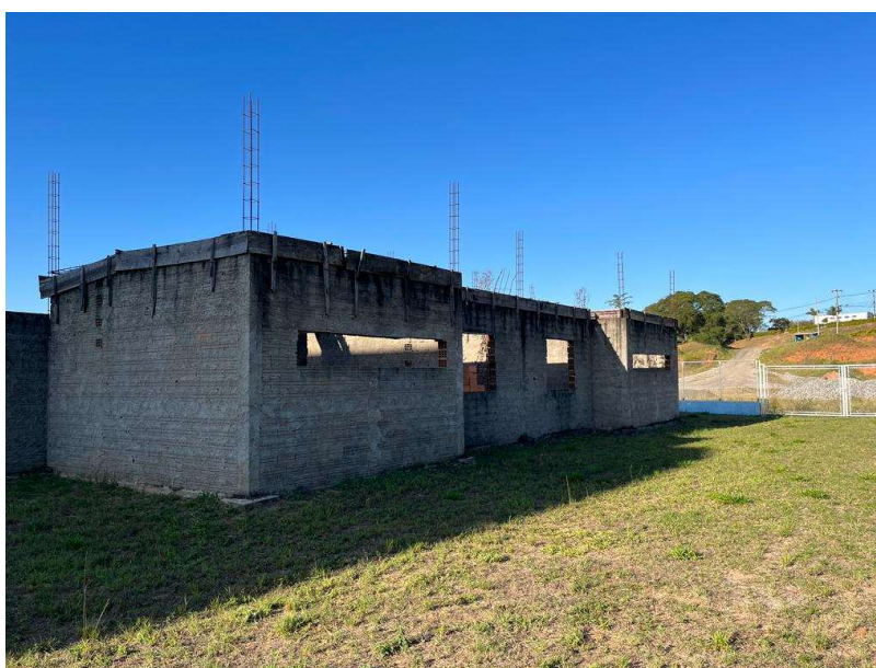
Imagem 2 – sistema estrutural e alvenaria após execução em 2016
