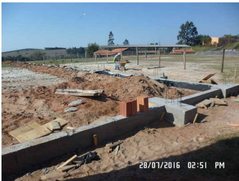
Imagem 1 – Fundação após execução em 2016
